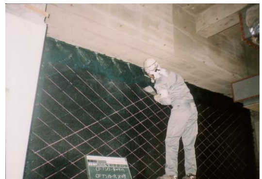
(b) CFアンカー取り付け方向を表示した例
