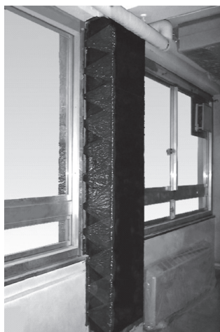
写真3 サッシ枠が付いた柱の補強
