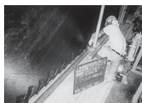
写真4 耐震壁の補強概要
