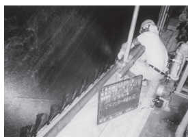
写真4 耐震壁の補強概要
