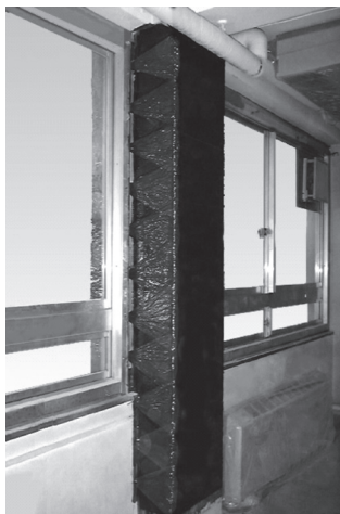
写真3 サッシ枠が付いた柱の補強
